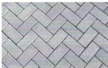
Piso de concreto intertravado com areia
