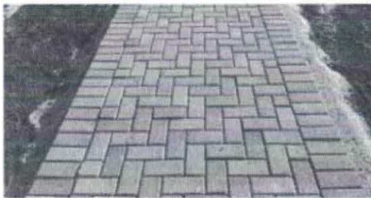
Lajota de concreto com rejunte de areia
