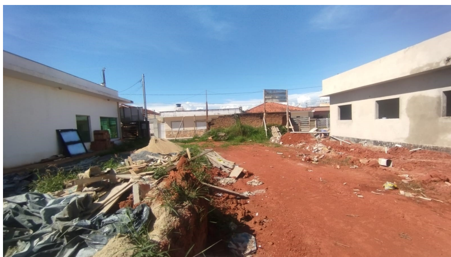
Foto 04: Fundos vista para o muro
